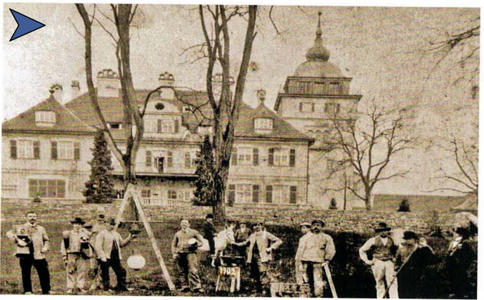
Arbeiten im Park, 1902
